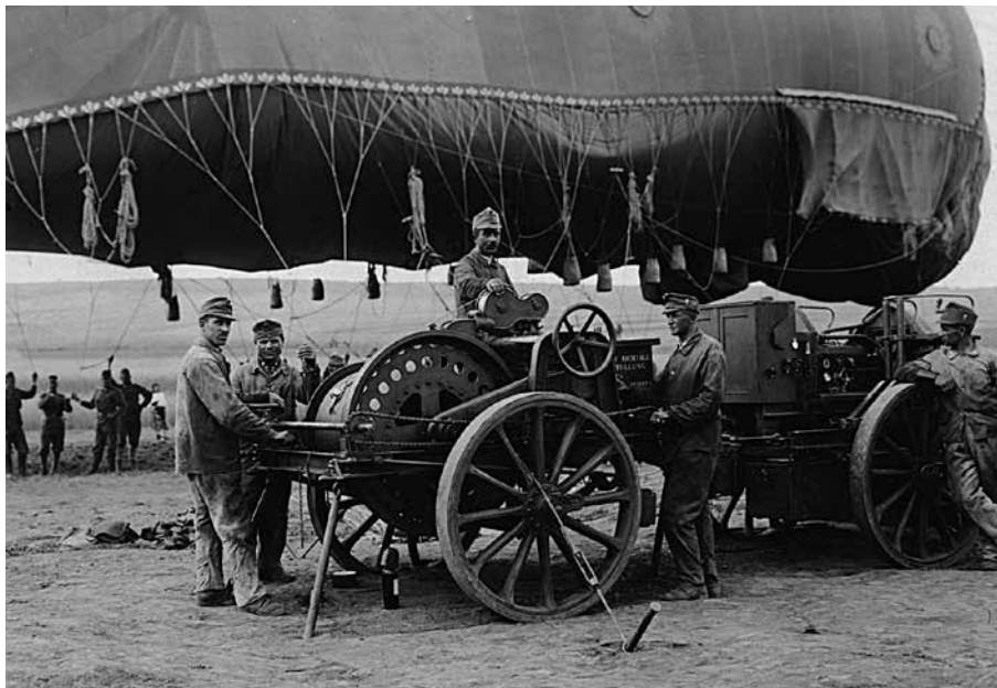
Az első világháború folyamán rendszeresített motoros csörlőkocsi és a hozzá tartozó 98 M ballon 1917-ben (HTM Fotóarchívum 11073/Fk)
