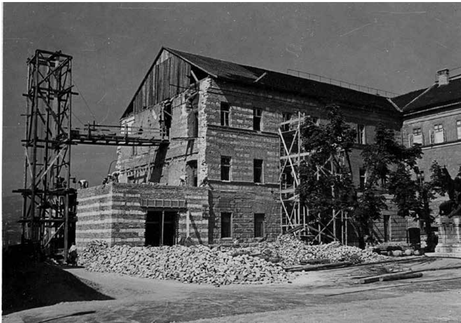
A leomlott délnyugati sarok újjáépítése, 1951. augusztus
