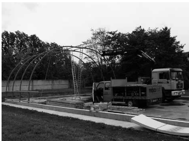
A csarnok összeszerelése
