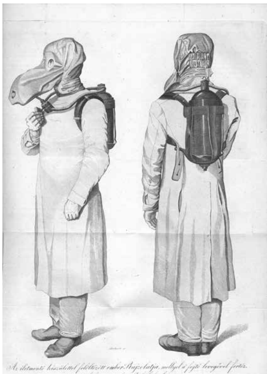
Mártony Károly találmánya, a sűrített levegőt használó légzőkészülék
