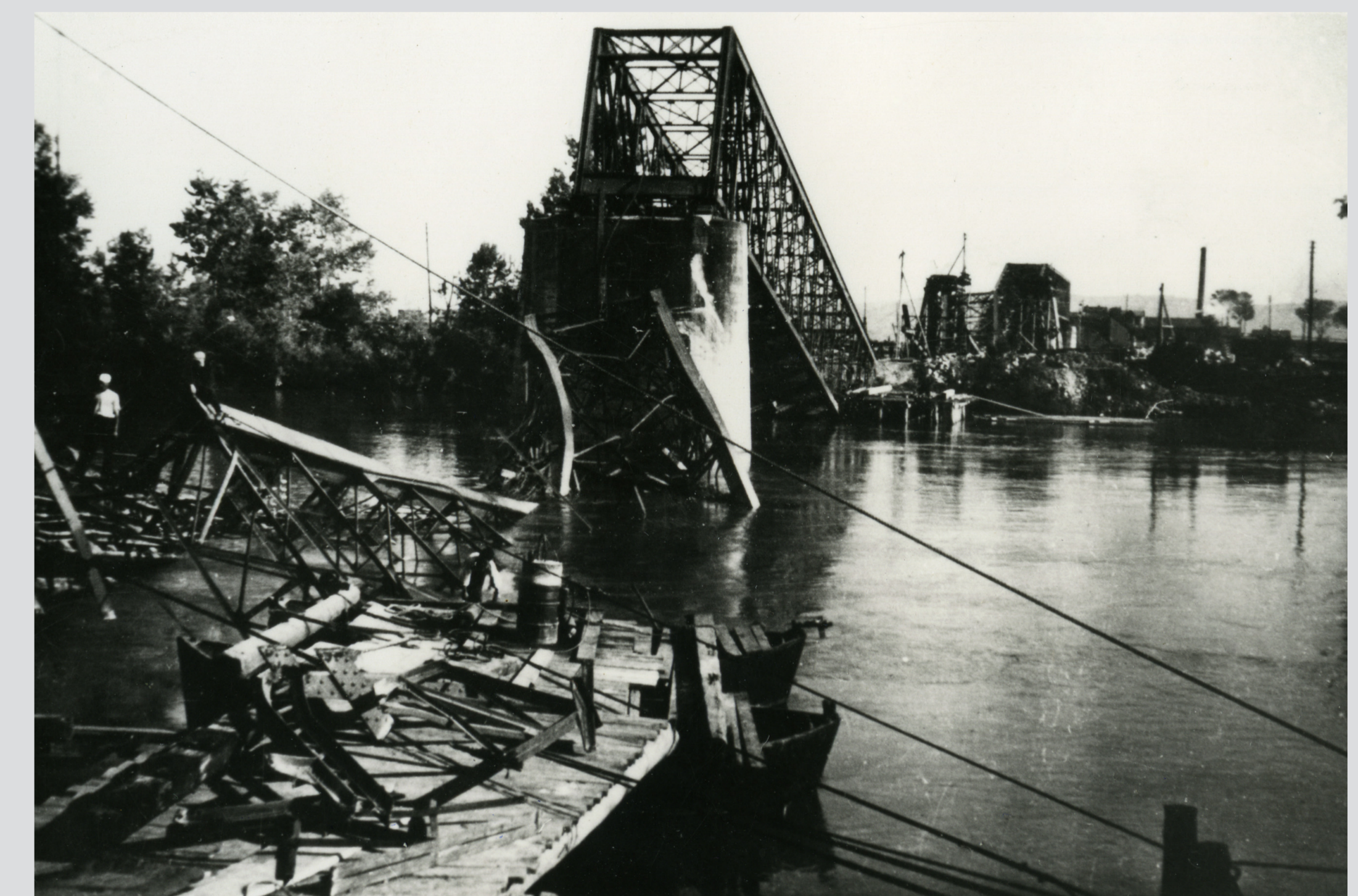
A felrobbantott Dráva híd Barcsnál, 1945. tavasza The destroyed Drava Bridge at Barcs, spring of 1945
