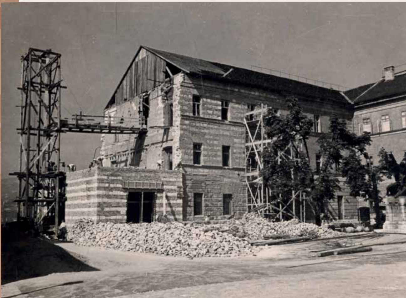
A déli szárny helyreállítási munkái, 1951
